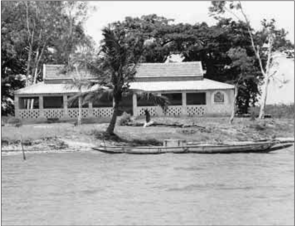
Réhabilitation du poste de garde de Djinack. L'amélioration des conditions de travail et de vie des agents chargés de la conservation est l'un des résultats attendus dans le cadre du 1 er objectif du plan de gestion de la RBDS (Photo: Mbodj).
